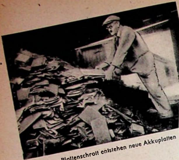
Abb. 1. Aus Plattenschrott entstehen neue Akkuplatten
