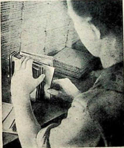
Abb. 10. Einfügen der Plattenscheider
