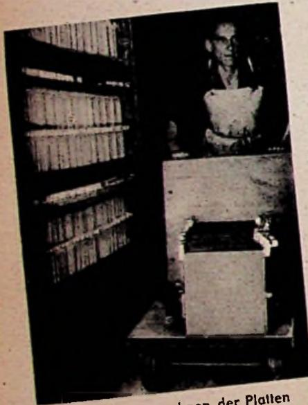
Abb. 7. Das Trocknen der Platten erfolgt in Heißluftkammern
